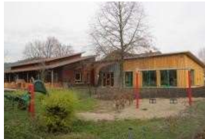
Kindergruppe 2019 Holz-Lehmbau und Eisspeicher
