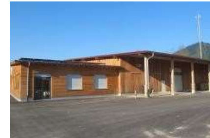
Bauhof 2020 Betonkernaktivierung und Eisspeicher
