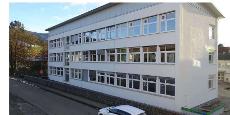
Unter anderem diese Schule wird zukünftig mithilfe der Abwärme einer lokalen Destillerie beheizt. (Foto: Fraunhofer-Institut für Solare Energiesysteme ISE)
