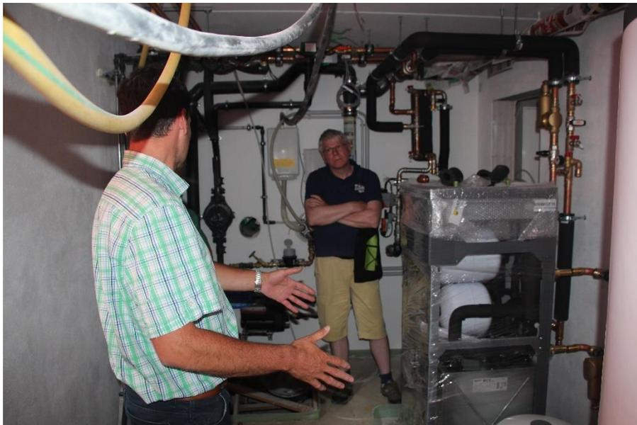
Ein Techniker der Stadtwerke Bühl (Betreiber) erläutert die Hausinstallation hier Wärmepumpe und hauseigener Wärmespeicher
